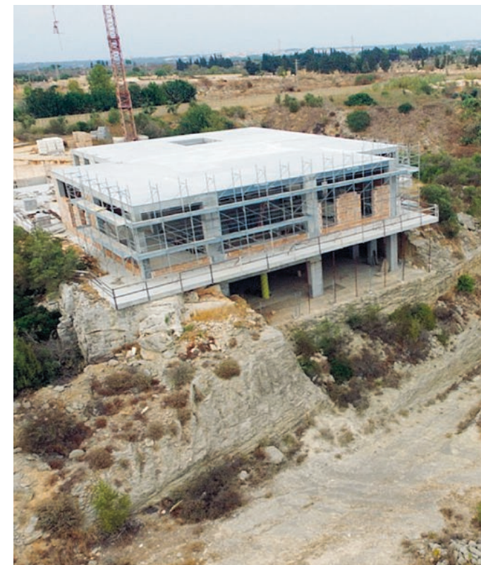
RICERCA Il Centro «Ilma» in fase di realizzazione a Gallipoli
